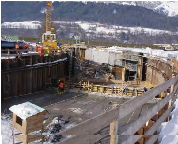
Herstellung Unterführung L224 Süd, 2005
